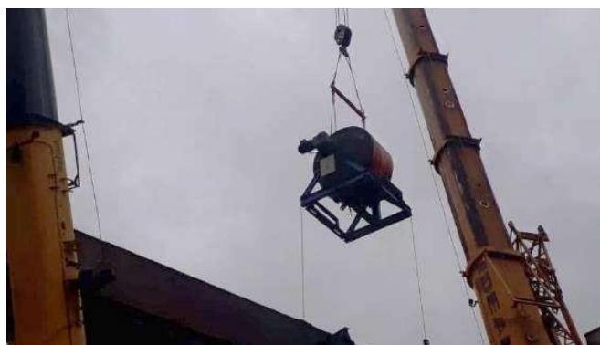
Dispositivos de içamento e cordas guia.
