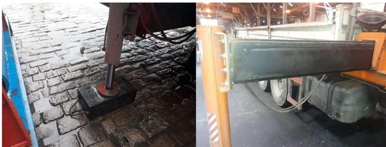
Patolamento adequado do equipamento.
