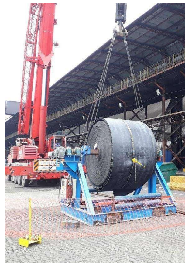
Área de trabalho isolada.
