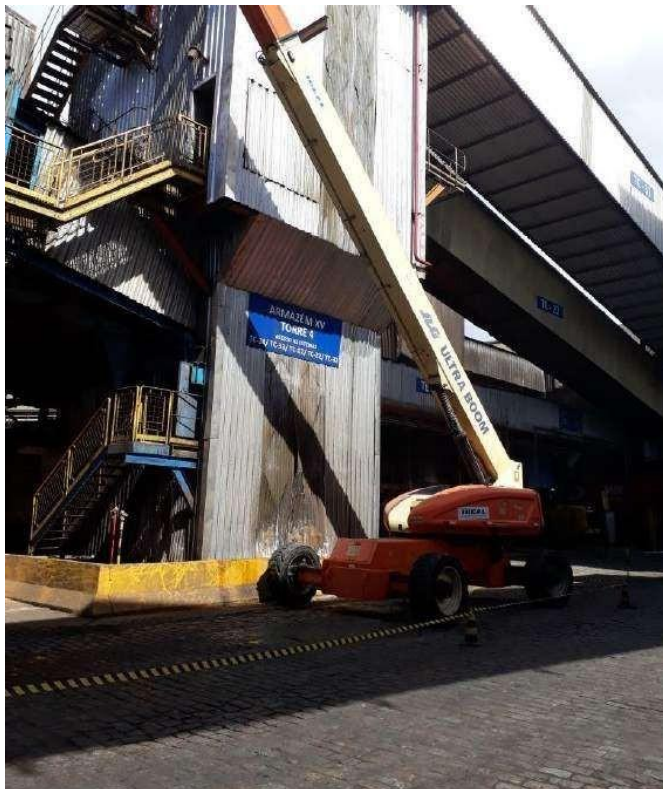
Área de trabalho isolada.
