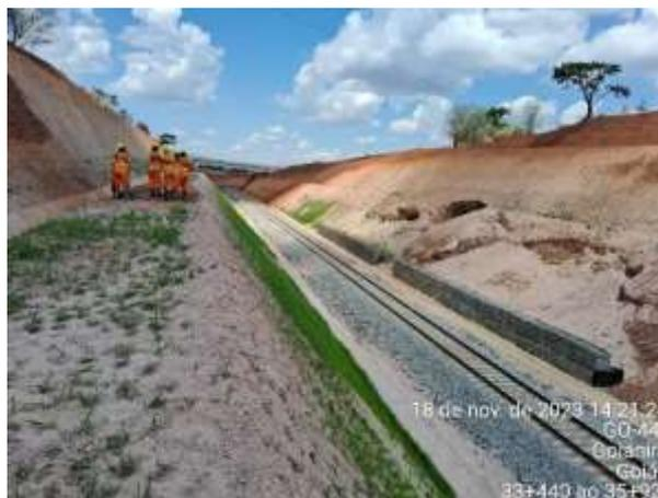
Figura 16 – Realização de manutenções após 15 dias da hidrossemeadura
