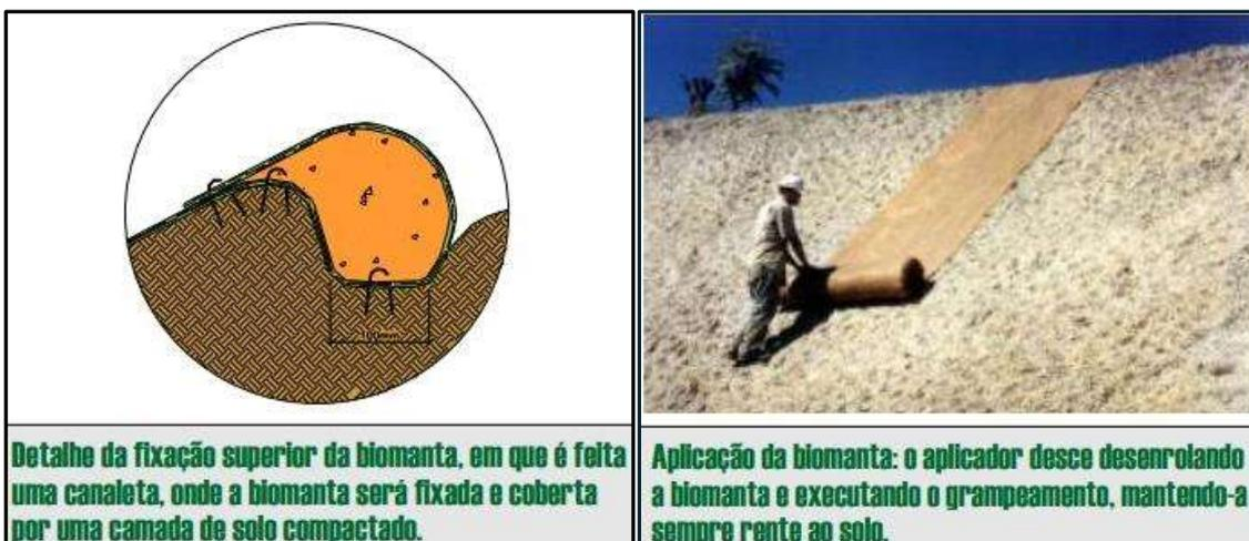
Figura 10 – Aplicação das bobinas de biomantas
