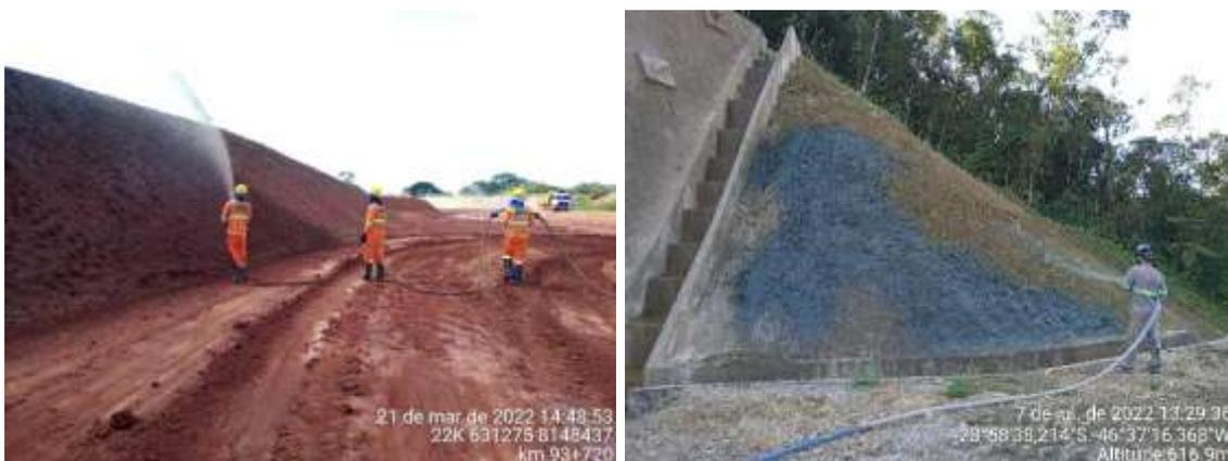
Figura 8 - Execução da hidrossemeadura em taludes
