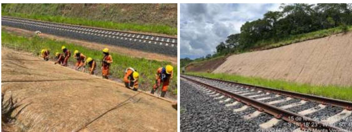
Figura 11 - Exemplos da aplicação da biomanta
