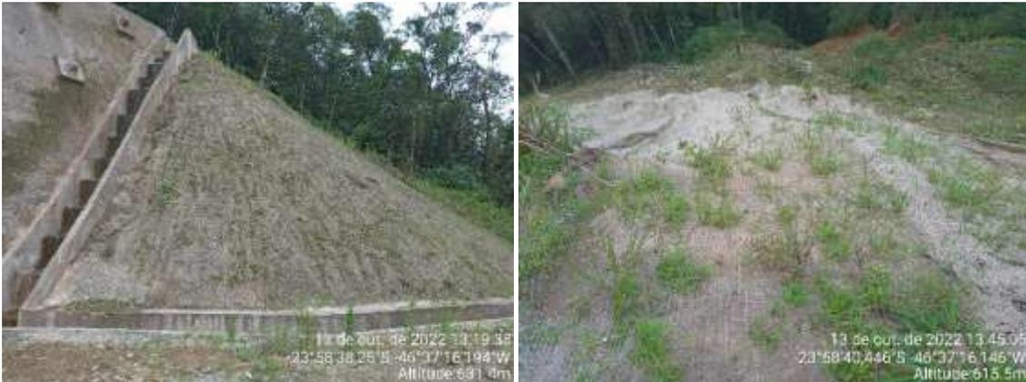
Figura 15 – Monitoramento de talude onde foi realizado hidrossemeadura
