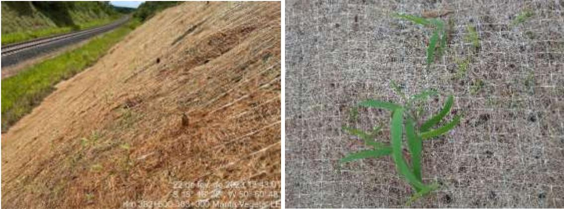
Figura 12 – Germinação bem-sucedida na utilização da biomanta com hidrossemeadura
