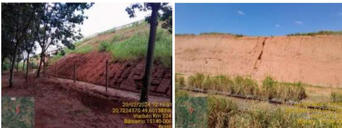
Figura 20 Taludes desprotegidos com indícios de erosão
