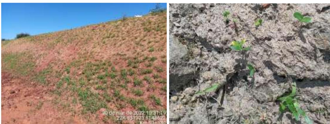
Figura 14 – Monitoramento realizado na área após 15 dias da execução da hidrossemeadura
