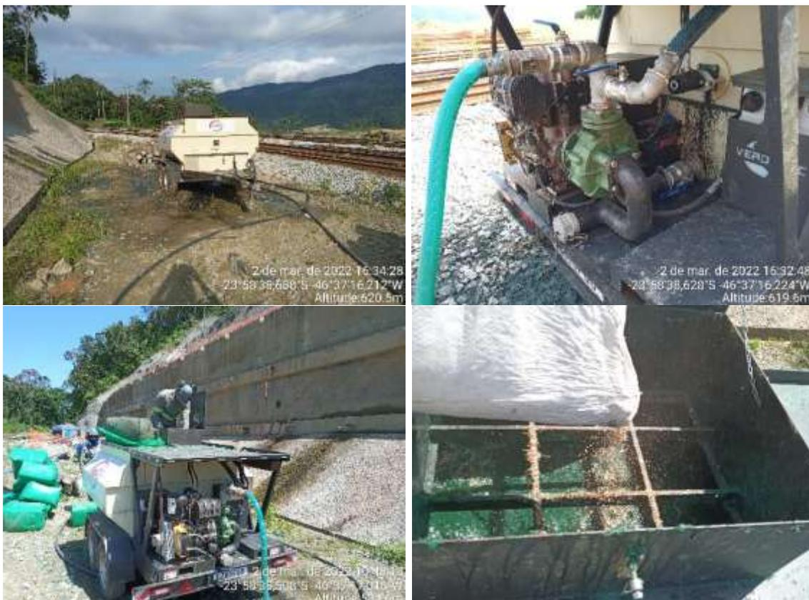
Figura 7 – Equipamento para hidrossemeadura
