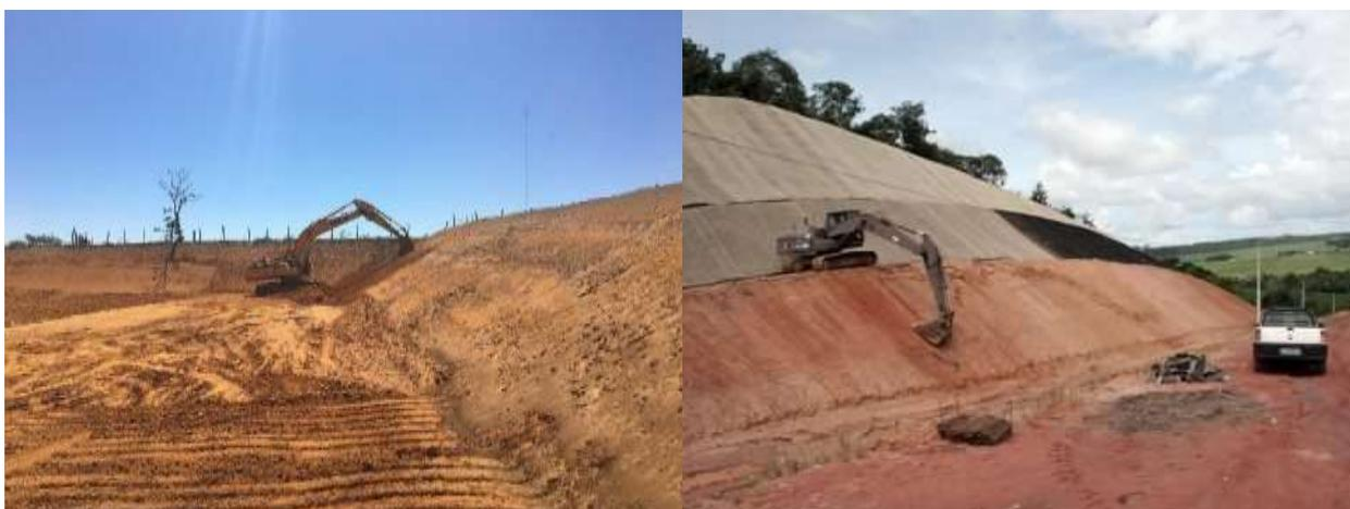
Figura 2 – Acerto e regularização de talude
